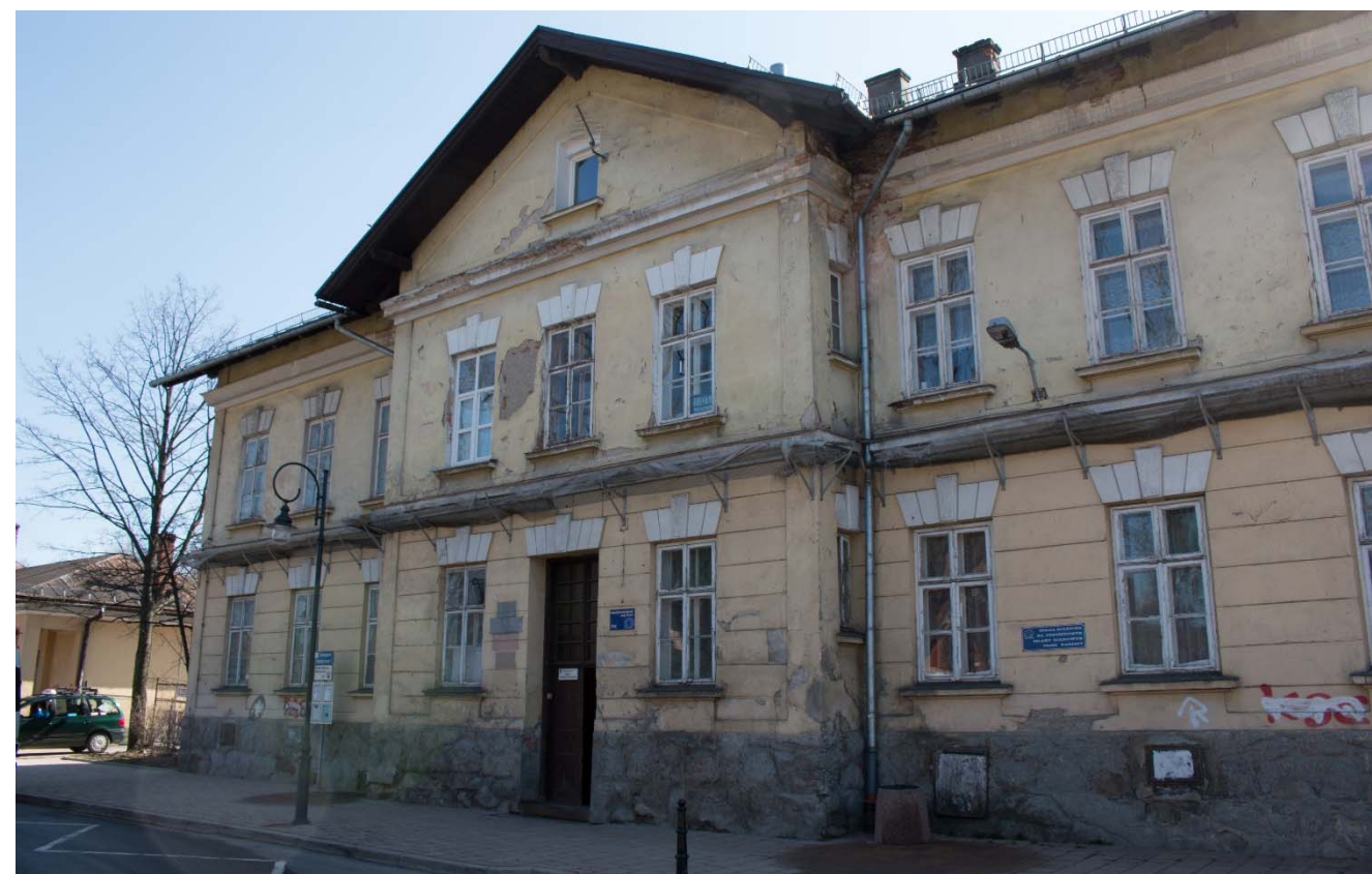
Rys. III.2.35 Zamieszkane budynki zdekapitalizowanego zabytkowego kompleksu dworcowego
