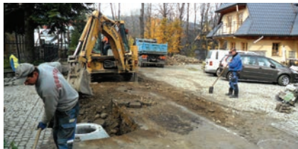
Przebudowa dróg ul. Króle, Chłabówka Górna, Tatary, Kotelnica, Małe Żywcańskie
