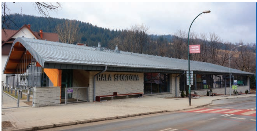
Nowa hala sportowa - teren szkoły przy ul. Chramcówki. Wydatki na inwestycję w latach 2015 - 2017 wyniosły 7,9 mln zł.
