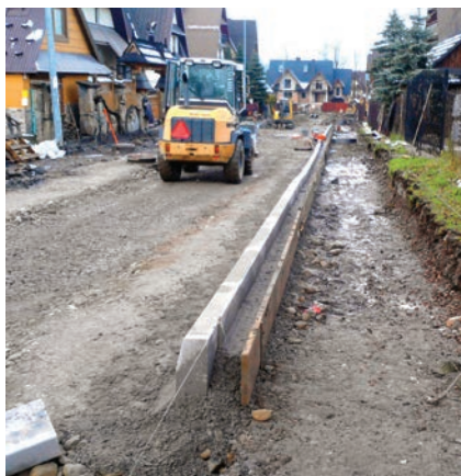
Przebudowa ul. Podhalańskiej Bocznej wraz z budową chodnika i odwodnienia
