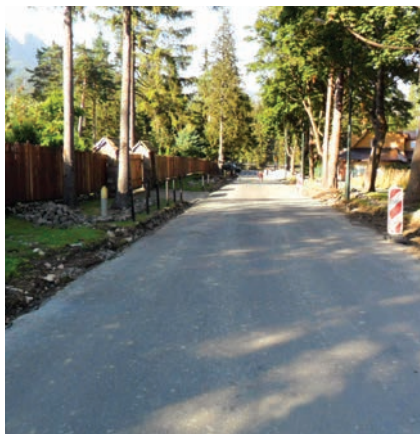
Przebudowa drogi wraz z infrastrukturą – ul. Sabaty
