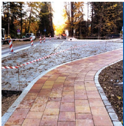
Przebudowa ul. Przewodników Tatrzańskich wraz ze ścieżką rowerową – II etap
