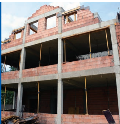
Budowa Przedszkola przy Szkole Podstawowej nr 9
